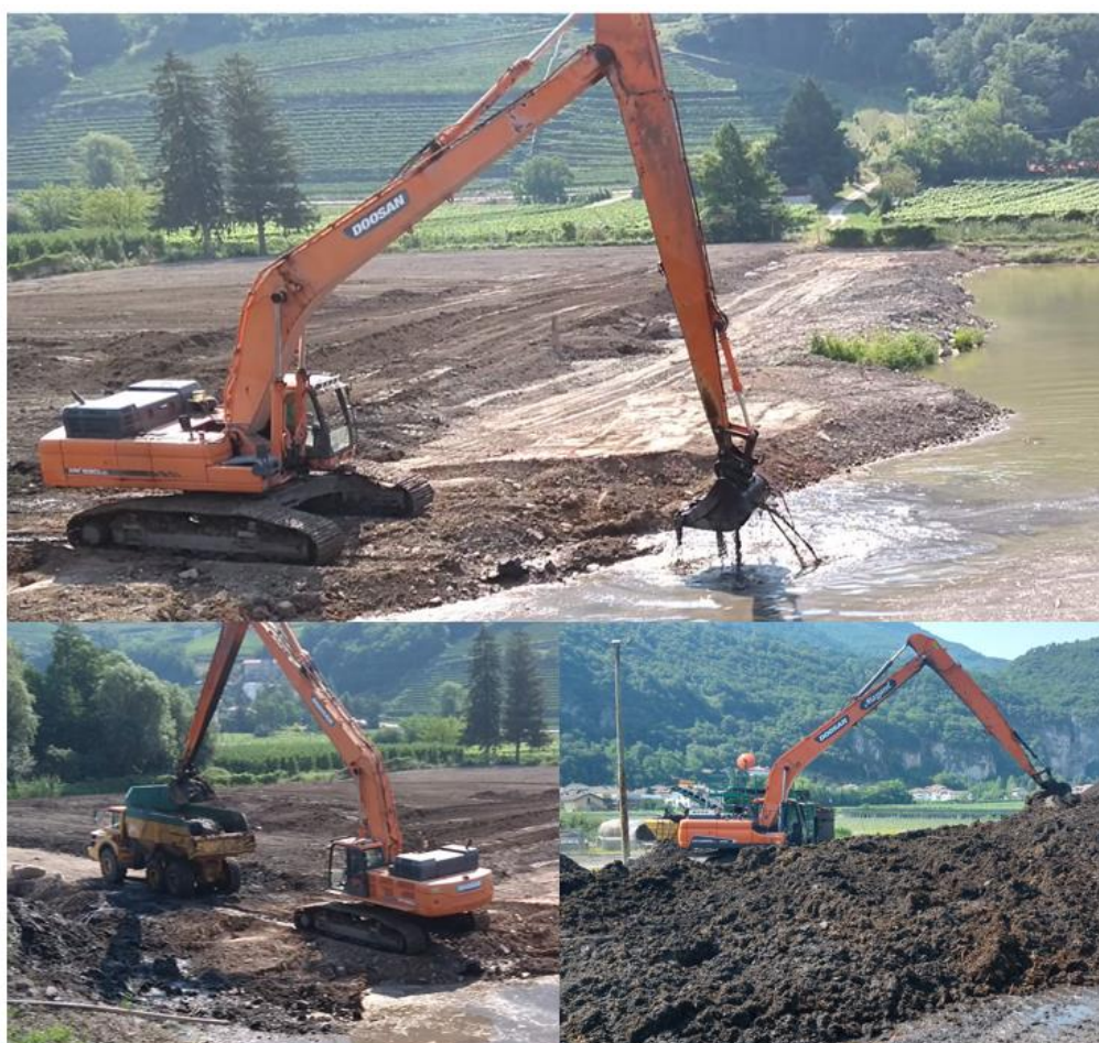
Abbildung 4: Torfentnahme mit Spezialbagger und Verladung auf den Schlepper
